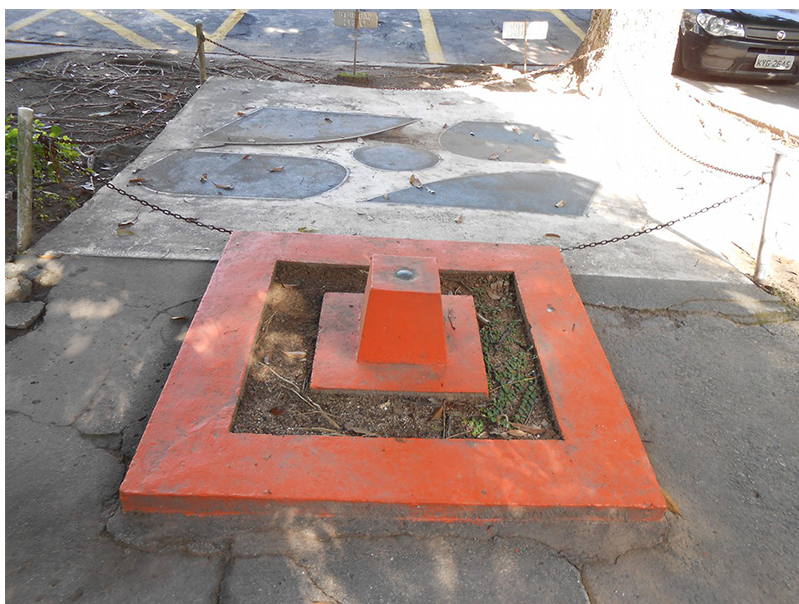
Estação passiva, marco padrão IBGE. A cor laranja é utilizada para facilitar a localização. A chapa, com o código da estação, é fixada no topo.
